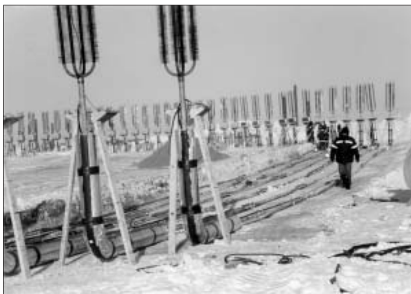
Рис. 1. Укладка термостабилизаторов на грунтовое основание
