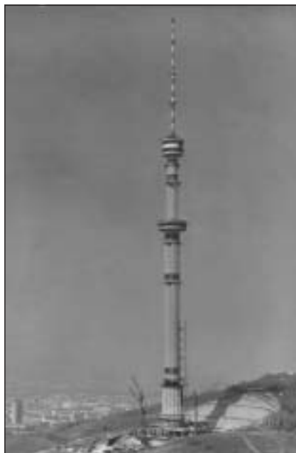
Телевизионная башня в Алма-Ате высотой 326 м. Конструкция фундамента разработана Фундаментпроектом
