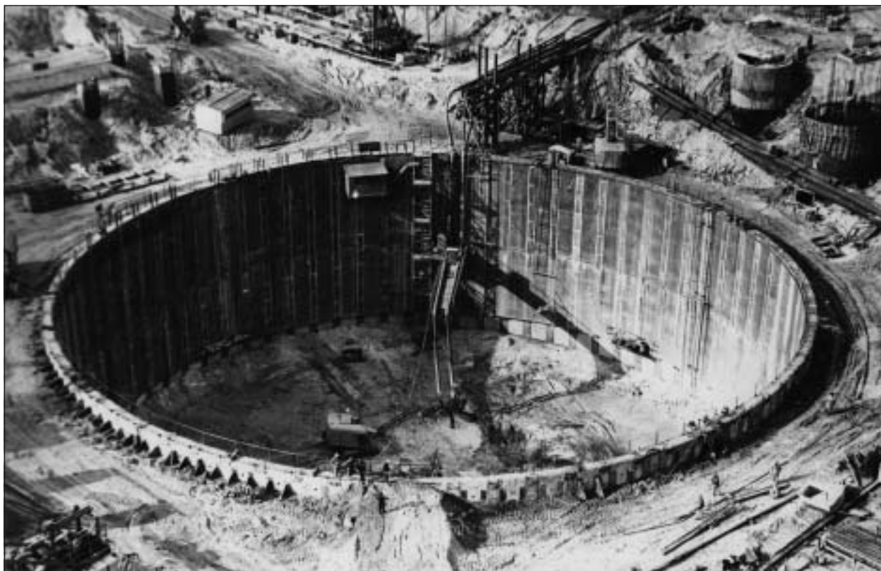
Опускной колодец скиповой ямы для доменной печи № 5 Новолипецкого металлургического завода. Проект погружения колодца, выполненного из сборного железобетона, разработан Фундаментпроектом. Диаметр колодца — 60 м, глубина — 20 м
