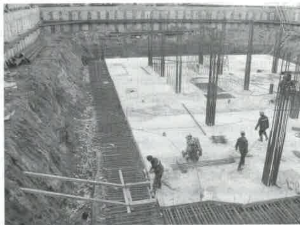
Рис. 3. Устройство ограждения методом "стена в грунте" и фундаментной плиты
