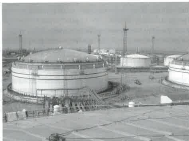
Рис. 2. Общий вид резервуара, Варандейский нефтяной отгрузочный терминал
